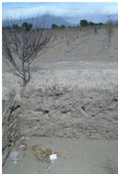
Construcción de un depósito para captación de agua de lluvia para riego en un huerto.
