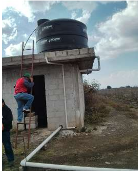
Figura 6. Sistema de captación de agua de lluvia para regar un huerto de manzano en José María Morelos, municipio de Tlachichuca, Pue. El sistema está compuesto por el área de captación, que es el techo de la construcción, por una cisterna; una bomba para elevar el agua desde la cisterna hasta el depósito superior; de un filtro y un sistema de riego por goteo. Observe al fondo las mangueras de riego por goteo entre los árboles.
